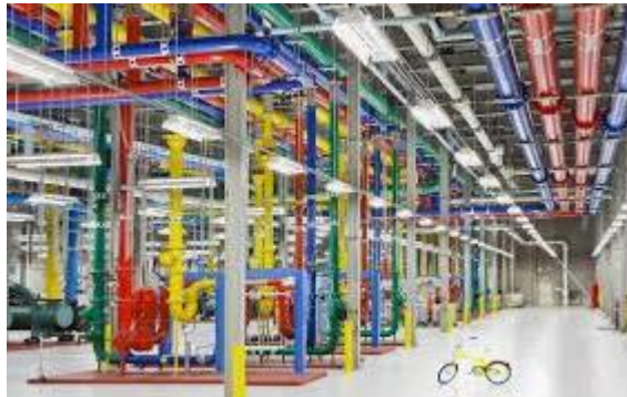
شکل ۳: به کار گیری رنگ در شناسایی مسیر سیال های مختلف در موتورخانه
