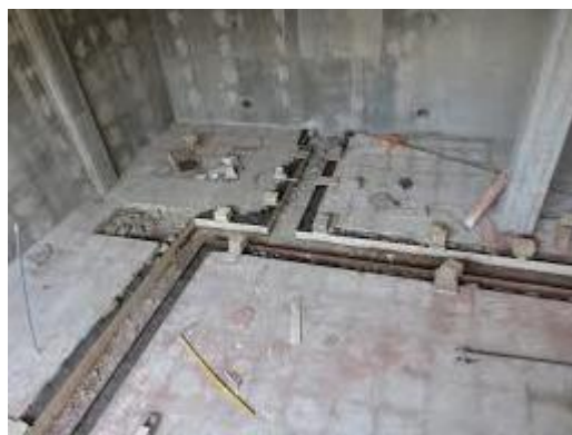
شکل ۲: کانال کشی کف موتورخانه
