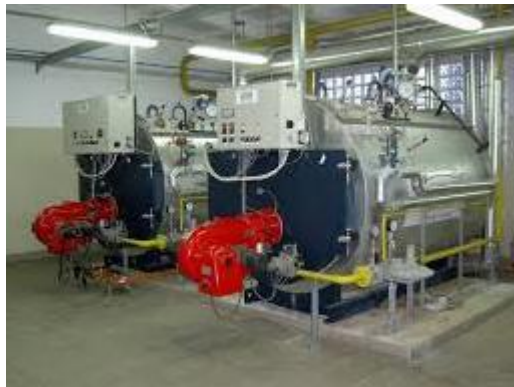
شکل ۱: نصب بویلر روی فونداسیون
